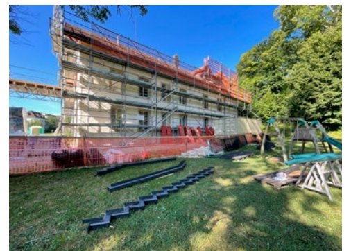
Travaux de la Maison Butini en juillet 2025
