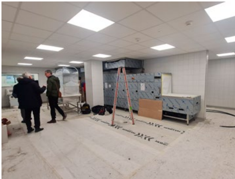
Visite du chantier de la cuisine de l'hôpital en décembre 2025
