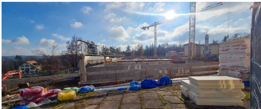
Chantier de l'ESSC en novembre 2025
